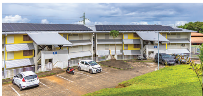
Panneaux photovoltaïques - Résidence Les Terrasses de Raban à Cayenne
