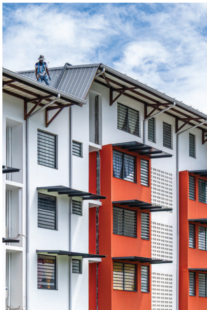
Panneaux photovoltaïques - Résidence Mandela à Cayenne
