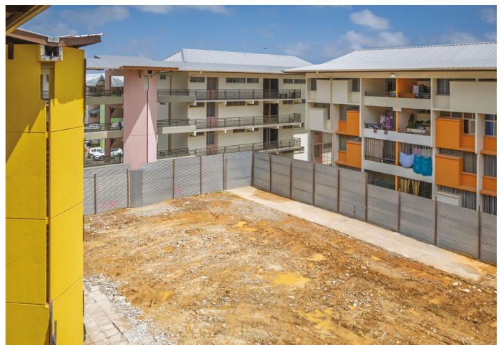
Zone de démolition terminée
