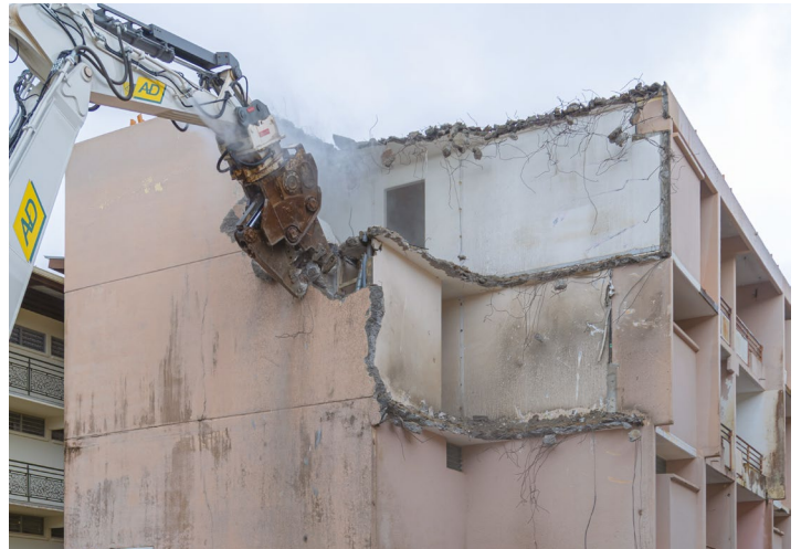
Démolition mécanique à la pince hydraulique
