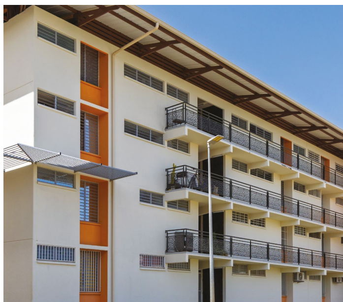
Immeuble réhabilité - Mont-lucas II à Cayenne
