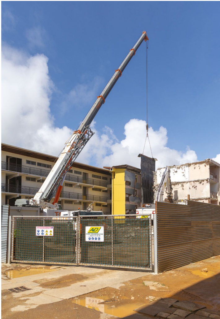
Bâche de protection des gravats
