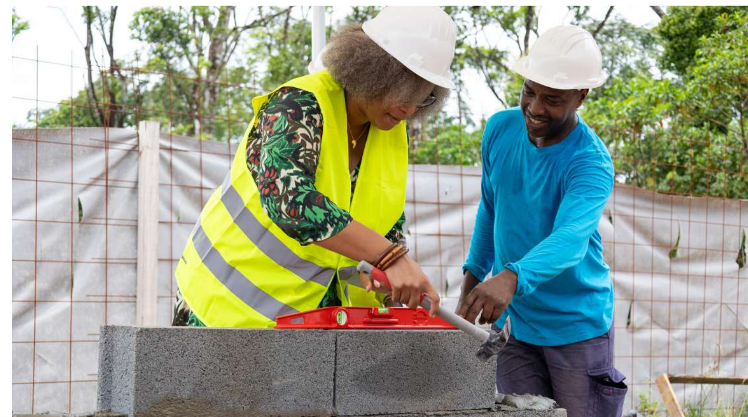
Pose de la 1 re pierre du groupe scolaire Crique Anguille à Matoury
