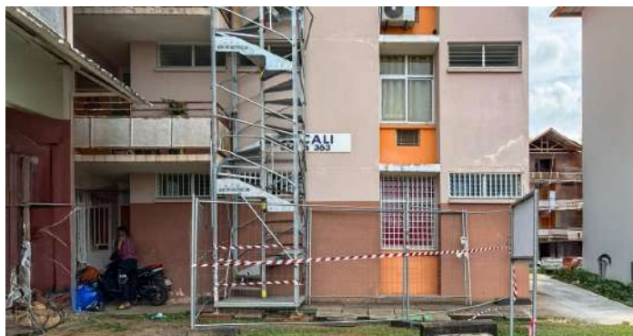
Quartier de Mont Lucas 2 avant réhabilitation
