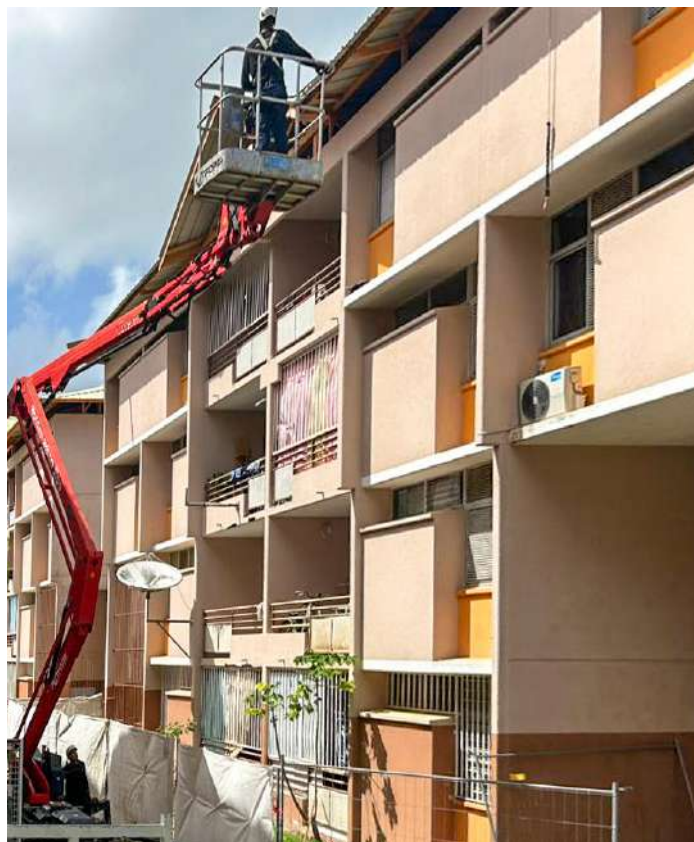
Quartier Mont Lucas 2, intervention sur les toitures
