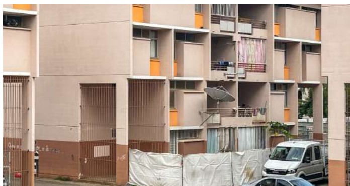
Quartier de Mont Lucas 2 avant réhabilitation
